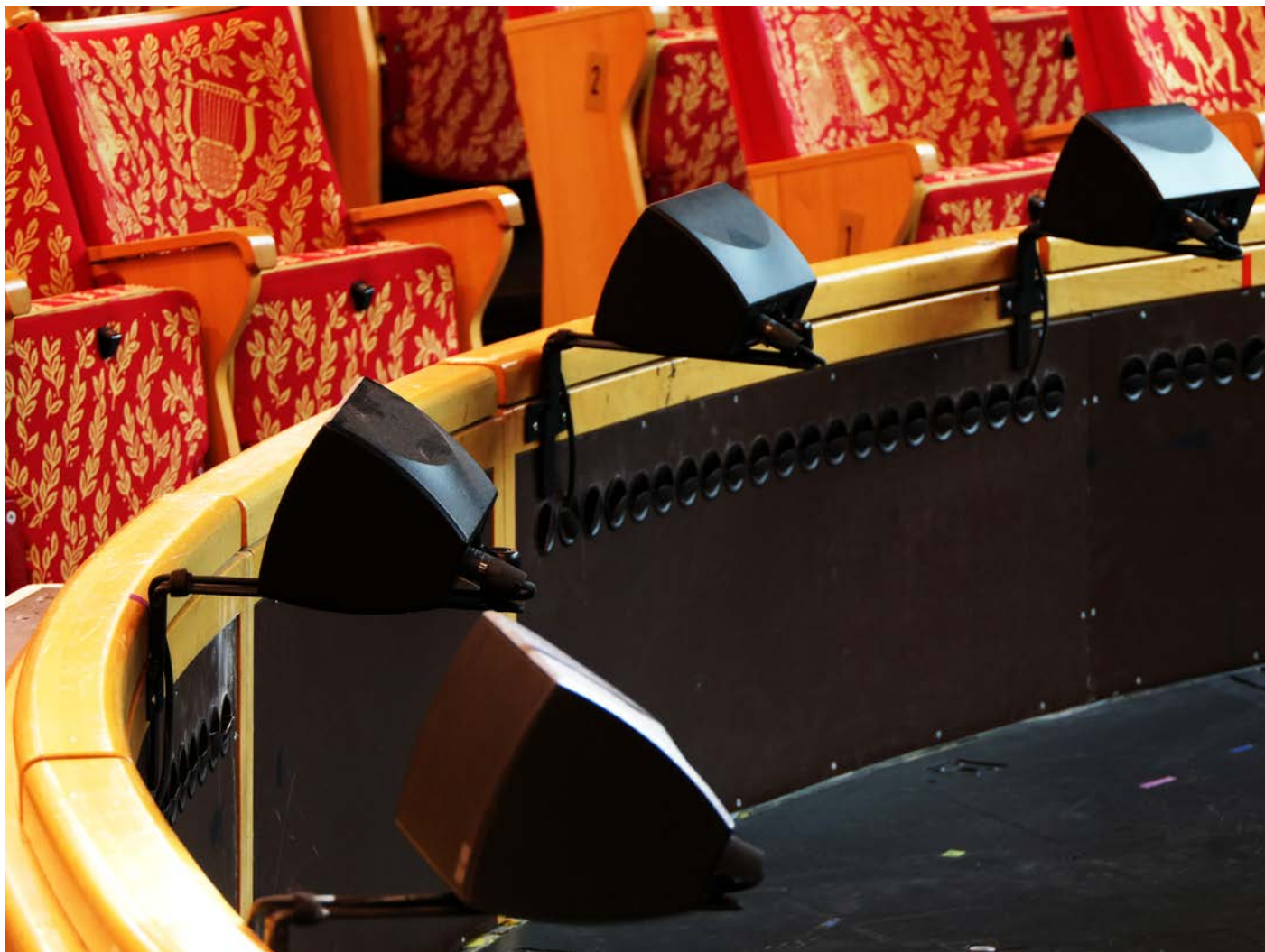
Malmö Operan är en av tre platser i världen som använder Soundscape-systemet fullt ut idag. Malmö Operas system består av runt 100 högtalare.
